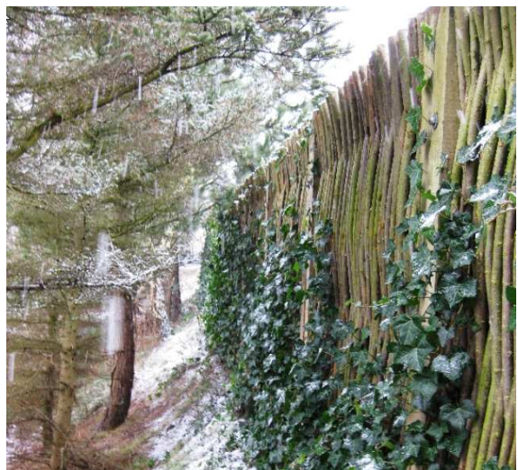
Bullerskyddsskärm i pilträdd, med stålram och absorberande stenull. http://www.byggros.com/sv/produkter/4000-stodmurar-bullervallar/den-naturliga-bullerskarmen
