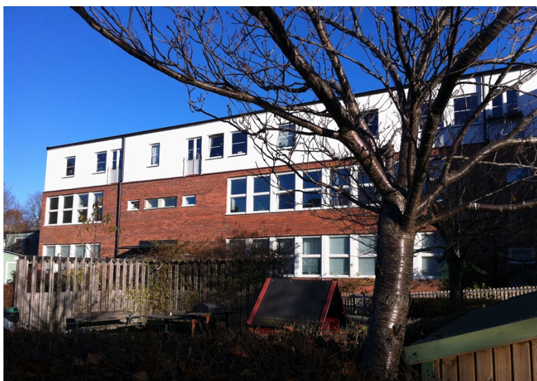
Befintlig byggnad. Våning 1 och 2 är före detta skolbyggnad, våning 3 är påbyggnad som tillkom på 90-talet.
