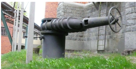
Gasregulatorer och stolpverk för gasledning. Foto: Nyréns Arkitektkontor.
