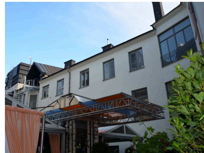
Den södra flygelns gårdsfasad. Till vänster ses "hållet" efter ett av de rivna gårdstrapphusen, som har ersatts av en utvändig spiraltrappa.
