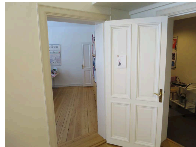
Återanvänd äldre träfyllningsdörr, sentida dörrfoder, och ursprungligt trägolv.
