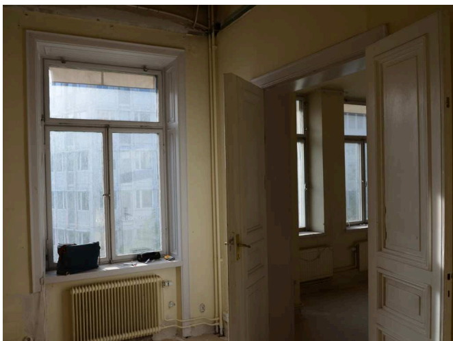
Fönster från 1930-talet, fönsterpaneler och foder från slutet av 1900-talet och återanvända äldre träfyllningsdörrar på våning 3 trappor.
