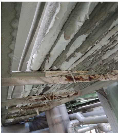
Skadade ledningar.
