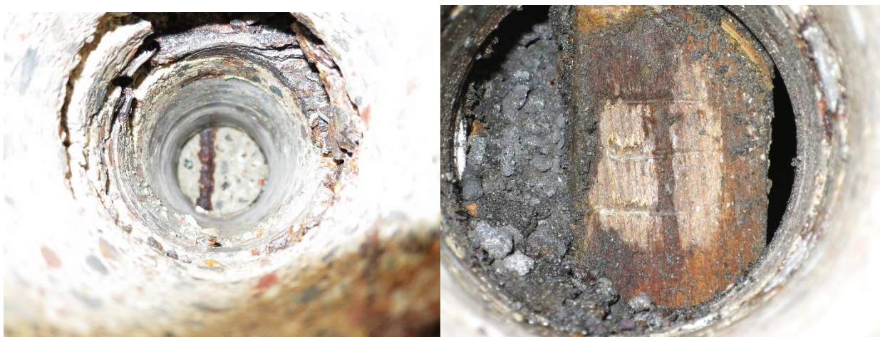
Bild 13. Borrhål i ficka F55 med skiktad betong och kol/virke innanför. Väggen är 36cm tjock.
