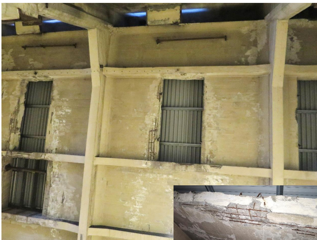
Bild 9. Frilagd armering kring hål i tak.
