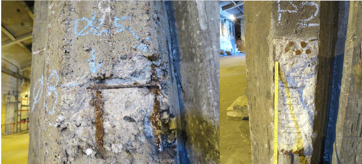
Bild 4. Skadade åttkantiga pelare, P4 till vänster respektive P2 till höger med bortbilad anslutning.
