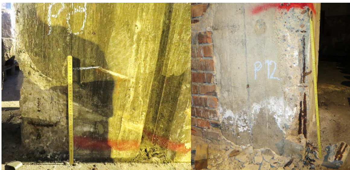
Bild 3. Spjälkskadade fyrkantiga pelare, P8 till vänster respektive väggpelare P12 till höger.
