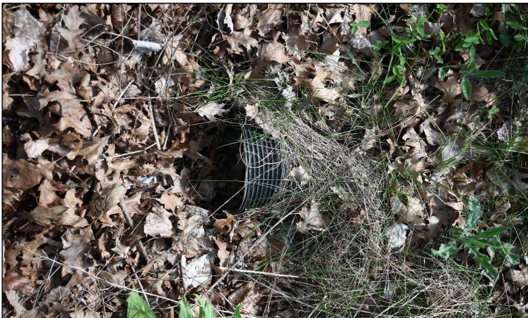
Figur 2:6. En ledning under gång- och cykelbanan som ligger norr om lågpunkt nr 1 (se Figur 2:3). Ledningen ska leda vatten till lågpunkten men kapaciteten bedömdes mycket begränsad till följd av igensättning.
