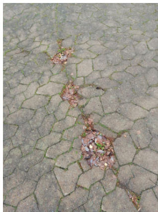
Sättningar i markmaterialet längs med en skarv.
