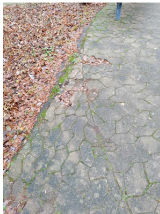
Sättningar av markmaterialet intill en kant. Missfärgad sten.
