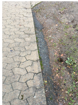
Asfalt mot kant av markbeläggning.
