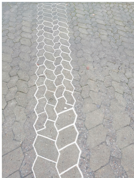
Bilderna längst ner visar sekvensen av stenar som successivt ändrar form och hur de fungerar ihop med standardstenarna.
