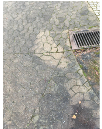
Sågning mellan riktningar. Mindre sättningar och missfärgade stenar.
