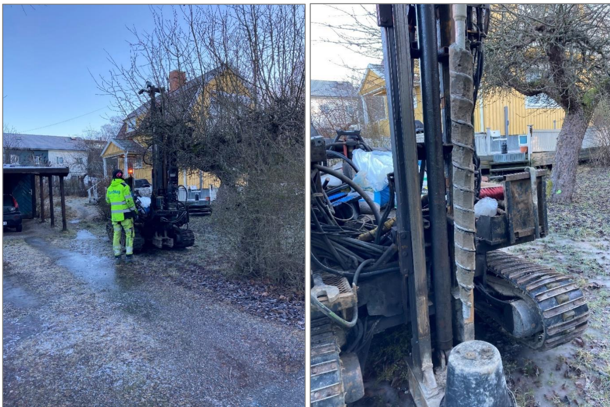
Figur 3-1. Jordprovtagning utfördes med en borrhandsvagn. I fotot till höger syns skruvprovtagning i provpunkt 22GS01.
