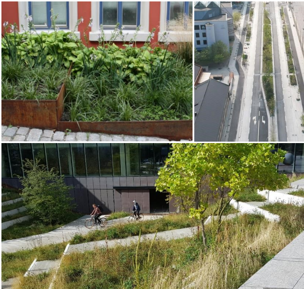
Figur 22. Vänster: Exempel på öppna terrasserade växtbäddar i Oslo. Höger: Exempel på huvudgata med stort inslag av grönutrymmen för dagvattenhantering, Neptunigatan i Malmö. Foto: Niklas Petersson. Båda från "Levande gaturum – en handbok i blågröngrå system". Under: Exempel på terrasserad dagvattenhantering i Köpenhamn, foto: Joakim Scharp
