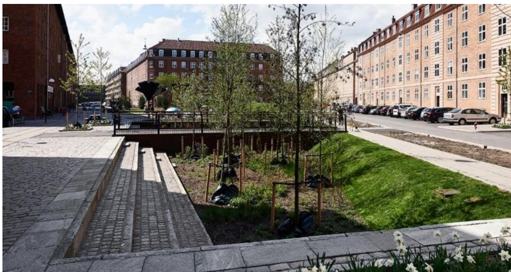
Figur 31. Exempel på ett torg med tydliga inslag av dagvattenhantering i nedsänkta grönytor, Tåsinge Plads i Köpenhamn.
