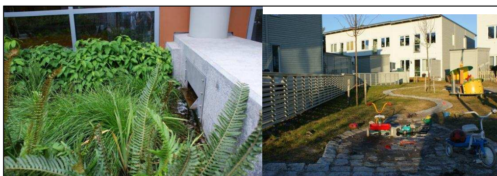
Stuprörsutkastare till växtbädd (tv) och stuprörsutkastare till ränna (th).
