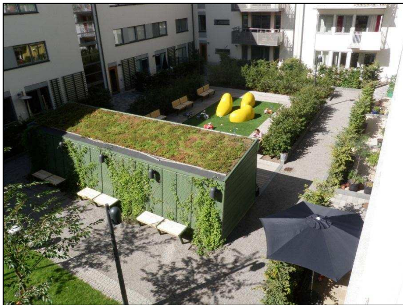
Figur 4. Lokal dagvattenhantering ovanpå bjälklag.
