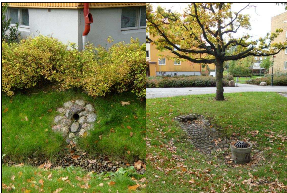
Erosionsskydd vid dagvattenutlopp i parkmiljö.
