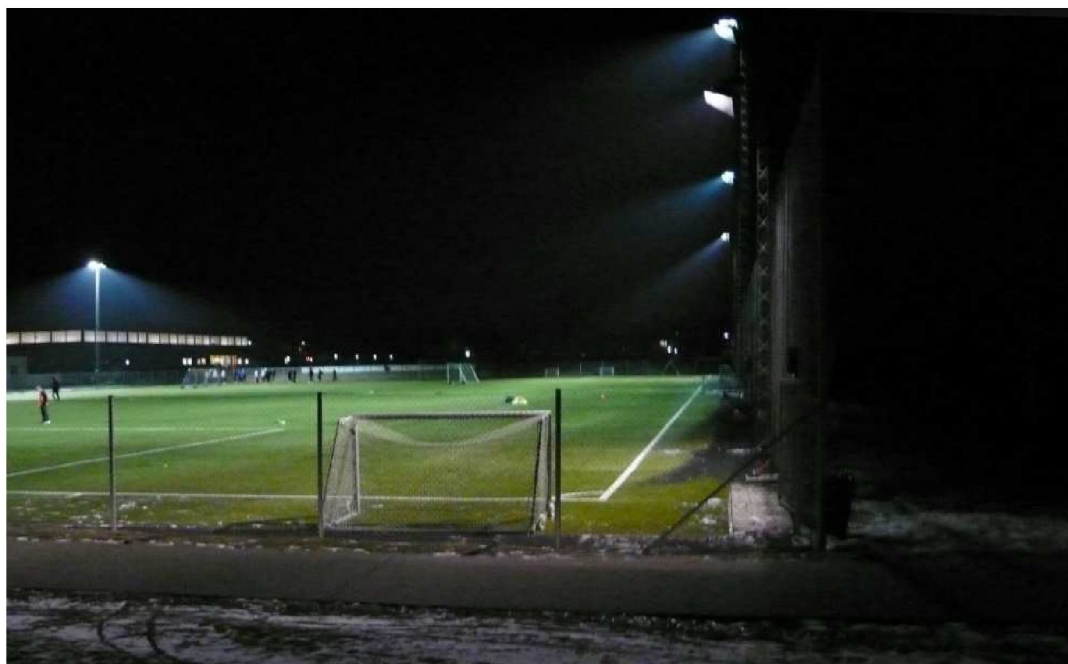
Bild 4 Specialtillverkad mekanisk avskärmning monterad på armatur skärmar av en stor del av ljuset som annars hade hamnat utanför planen.
