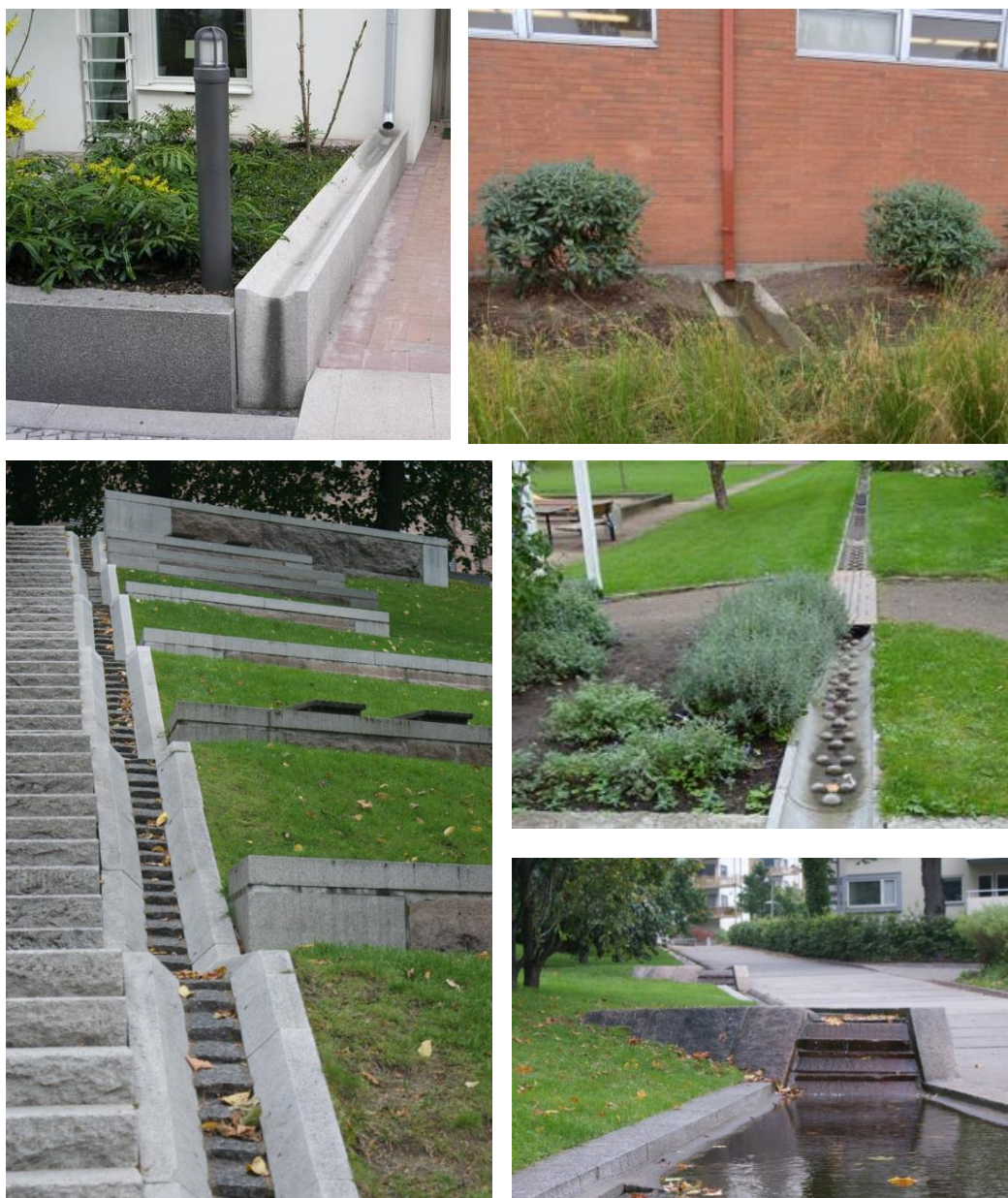
Figur 9. De övre bilderna ger exempel på stuprörsutkastare som ansluter till rännor. De nedre bilderna visar olika typer av rännor och ytlig avledning.
