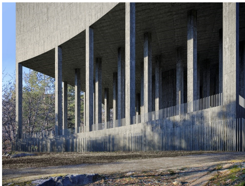
Staketet utformas med vertikala rör av rostfritt stål utan synligt fundament. Fallskydd i pelarsalen ges en utformning lika skalskyddet. Serviceytan närmast byggnaden utförs växtbklädd.
