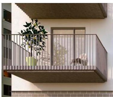
Balkong med pinnräcke. Den kan även utföras med perforerad korrugerad plåt. Balkongplattan i betong får en ursparning i framkant så att den upplevs nättare. (Bild White arkitekter)
