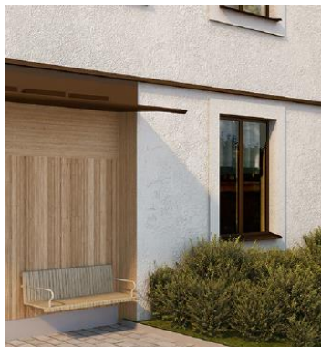
Sockelvåningen markeras med en plåtlist i samma kulör som övriga plåtdetaljer. Fönster i sockelvåning är högre än på övriga våningsplan. Bild White.
