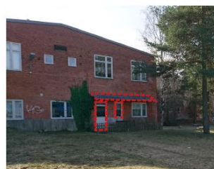
Figur 36. Kvarvarande del av den f.d. slöjdbyggnadens gavel mot tunnelbanan ändras genom att uteplats och skärmtak tas bort och fönster ändras. Ett befintligt fönster i plankartan (längst till höger i bilderna) kan ersättas av en ny entrédörr som via en ny takförsedd och uppbyggd gångväg med ramp och trappor leder vidare till Hus B och gård. Bild: Arkitema Architects.
