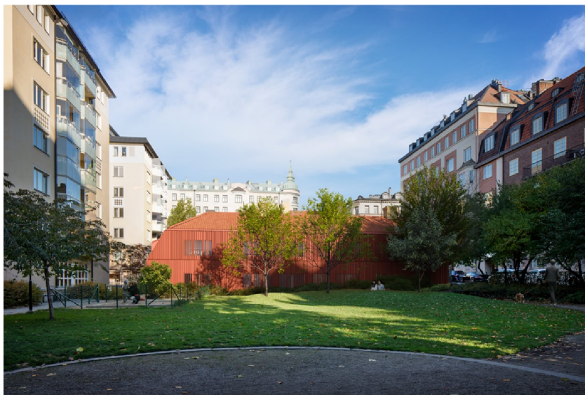
Perspektiv från Monica Zetterlunds Park. Flygelbyggnadens fasad utformas med färgad träpanel med utanpåliggande träribbor. Mot marken löper träribborna även över fönstren i syfte att mildra dess närvaro.
