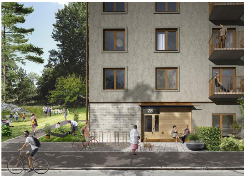
Sockelvåningen utförs i puts i samma kulör som fasad. Alternativt kan sockelvåningen helt eller delvis bekläs med tegel i kulör i likhet med fasad. Teglet muras på högkant. Entréparti utförs i ask eller ek samt med glas. Entrépartiet utförs något indraget och med skärmtak. Det kompletteras med identitetsbärande detaljer för Stockholmshusen såsom sittbänk, draghandtag och adresssiffra. Bild Dinell Johansson
