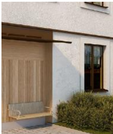
Sockelvåningen markeras med en plåtlist i samma kulör som övriga plåtdetaljer. Fönster i sockelvåning är högre än på övriga våningsplan. Bild White.
