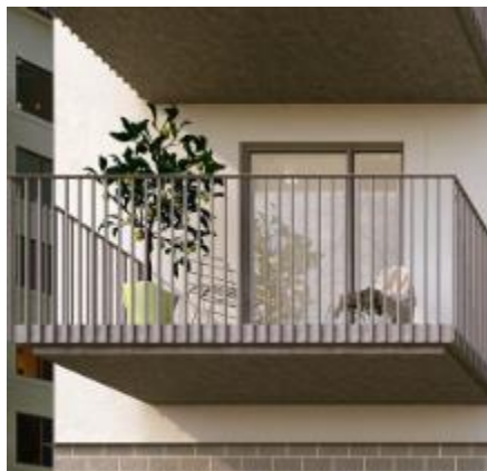
Balkong med pinnräcke. Den kan även utföras med perforerad korrugeradplåt. Balkongplattan i betong får en ursparning i framkant så att den upplevs nättare. Bild White.
