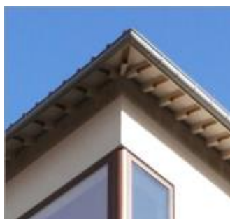
Takfoten ska utformas utstickande med synliga taktassar. Det skyddar fasaden och ger byggnaden ett lättare intryck. Bild Dinell Johansson
