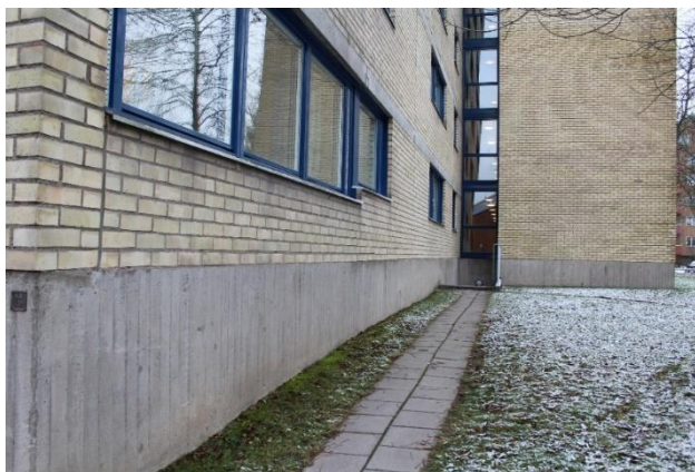
Bild 6 Exempel sockel i formgjuten betong. Hus C.
