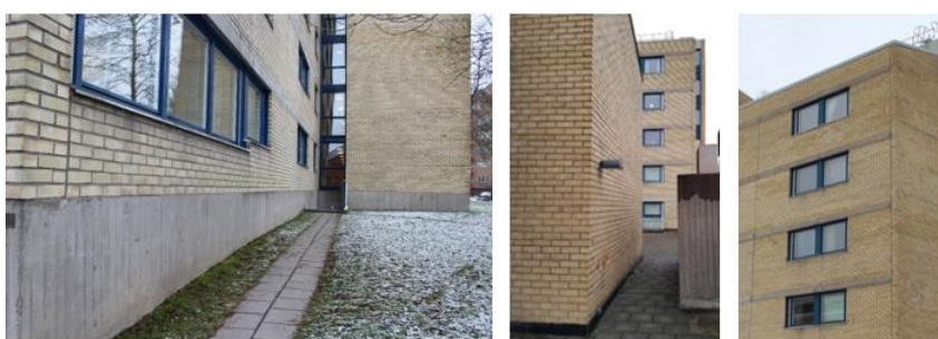
Exempel sockel i formgjuten betong, fasadtegel, synliga betongbalkar över fönster.
