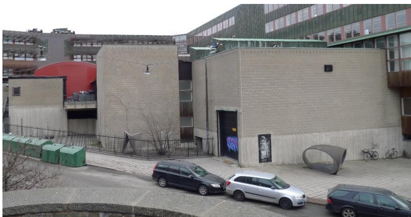
Fönsterlösa gavlar. Lågdelens ursprungliga yttermurar av betongblock och koppartak med lanterniner vid verkstaden. Små platser i vinklarna mellan huskropparna mot Uggeviksgatan.
