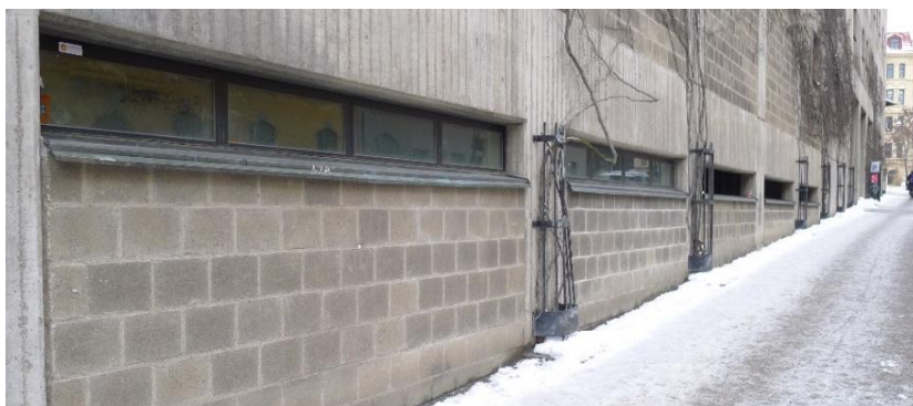
Markplanets öppningar i utfackningsväggar, här igenmurade fack med smal horisontell öppning i överkant.
