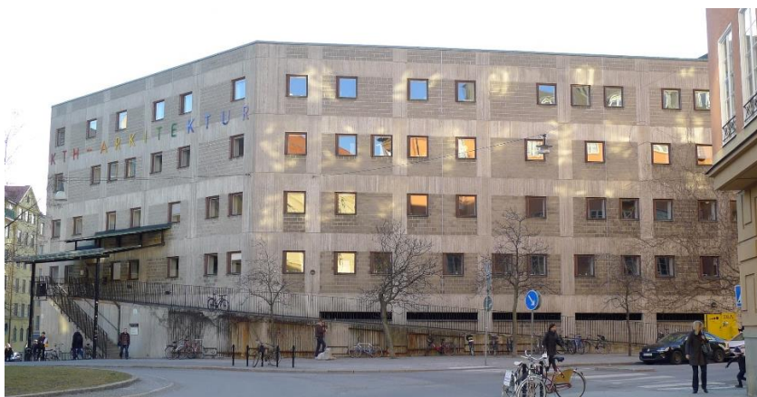
Högdels fasader mot Danderydsplan och Östermalmsgatan, med exponerad gjuten betongstomme, fyllningar av murade betongblock, likformiga fönsterhåll med oregelbunden placering i utfackningsväggarna. Högdels platta tak och rakt avslutade takfot framgår tydligt.
