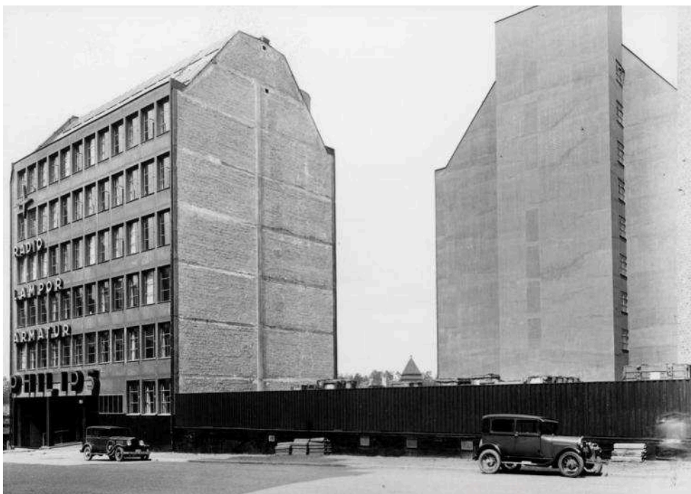
Gathuset och magasinet i början av 1930-talet. Båda byggnaderna fick platsgjutna fasader som målades med ockragul färg direkt på betongen. Entrén till fastigheten skedde genom portiken och markerades av den stora Philipsskylten.
