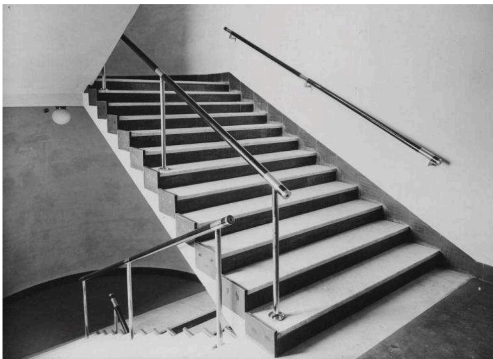
Trapphusinteriör med ursprungliga detaljer. Det eleganta trapphuset i Lewerentz gathus, med marmortrappa och handledare av stål och mahogny, stod i skarp kontrast mot byggnadens industriellt präglade exteriör. Trapphuset finns kvar i välbevarat skick.
