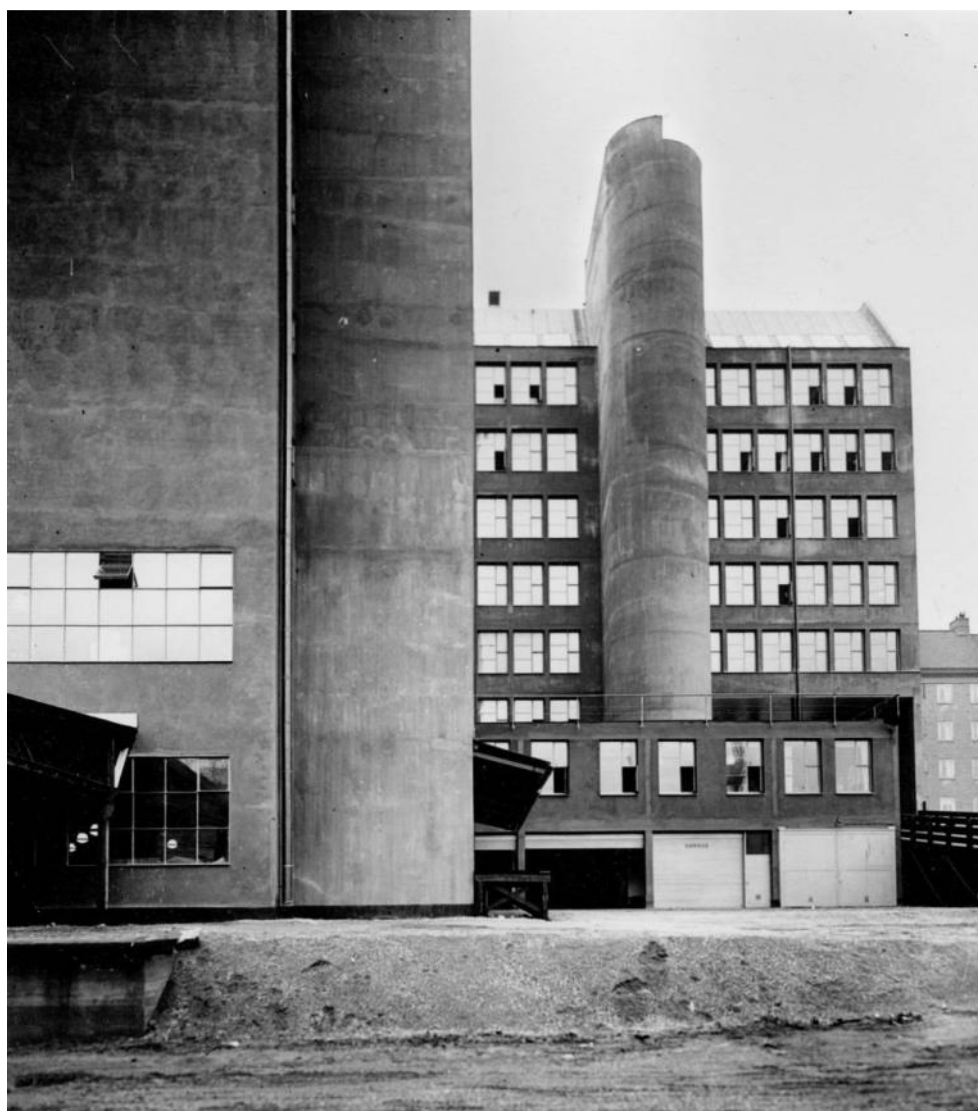
Tidigt foto av magasinets gavel och insidan på gathuset, som tydligt visar betongfasaderna med synliga gjutskarvar och spår av formbrädor. De kraftfulla tornkropparna innehöll hiss (magasinet) respektive trappa (gathuset).
