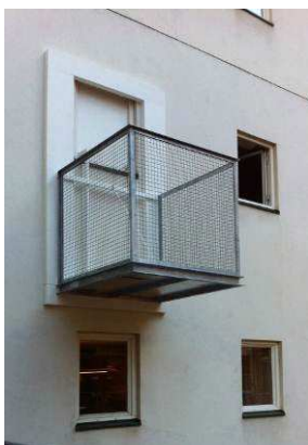
Prov med fullskalemodell av balkong på magasinet, storlek 1300x1300 mm.
