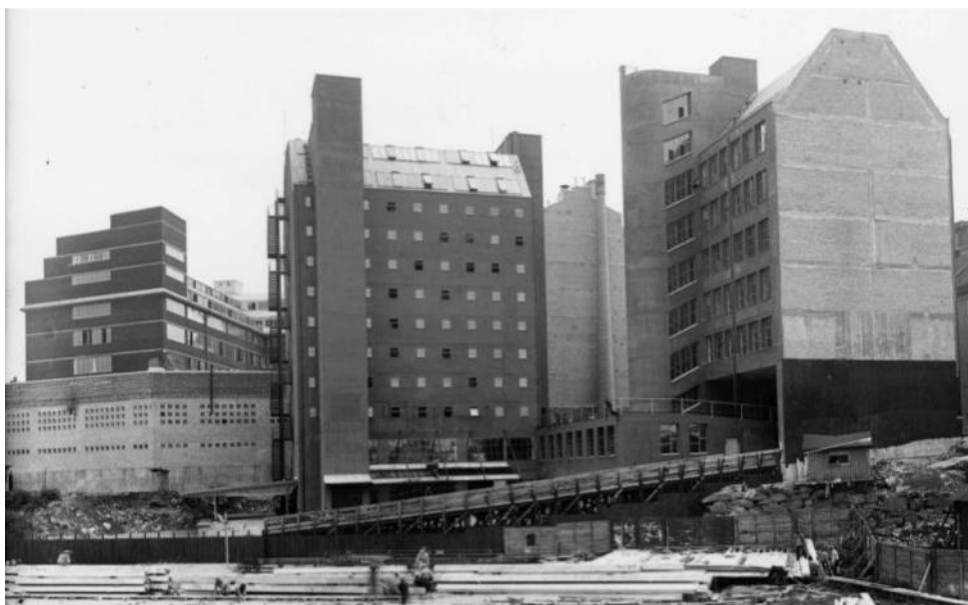
Philips anläggning från gårdssidan innan granntomterna hade bebyggts. Magasinet försågs med små kvadratiska fönster jämnt utspridda över fasadytan. Fönstren var av metall och placerade i ytterliv.
