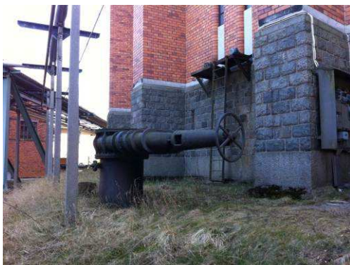
Bild gasregulator invid gasklocka 2.
