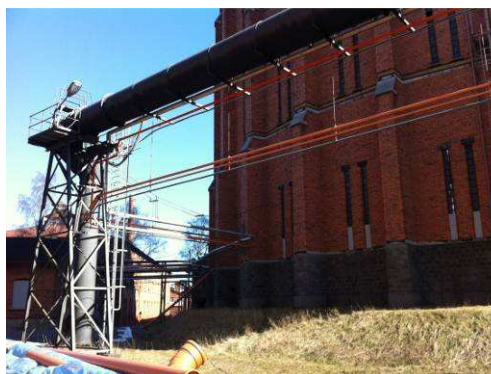
Bild luftledningsstråk mellan gasklocka 1 och 2.
