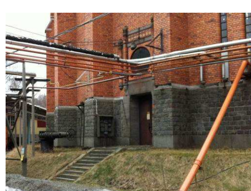
Stentrappa vid entré till gasklocka 2. Bilden visar även den ursprungliga portöppningen med skjutdörrar och mätartavla som ska bevaras enligt q3 ovan.
