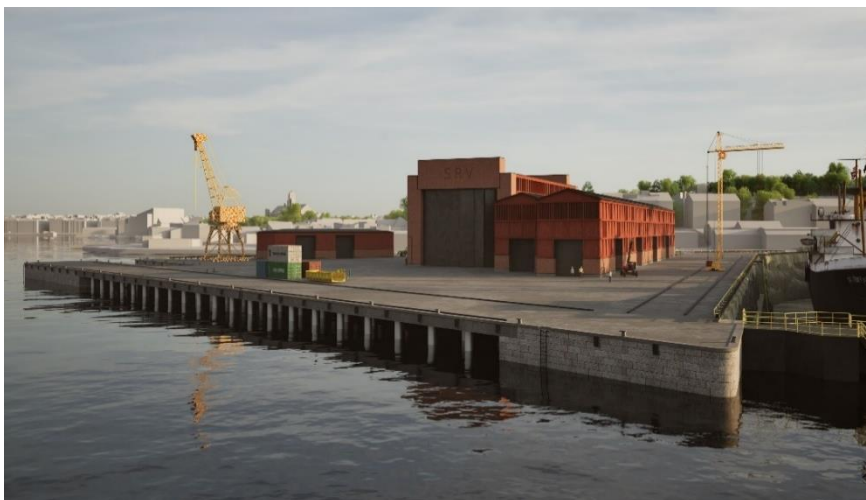
Södra kajen på västra Beckholmen utförs som ett pelardäck i betong mellan fundament med skoning i natursten.
