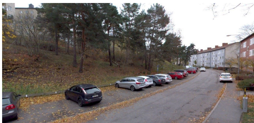
Figur 17. Befintlig situation på Tavelsjövägen. Körbanan är idag ca 6 meter bred, en smalare trottoar finns på gatans ena sida och på andra sidan är det tvärställda parkeringar.
