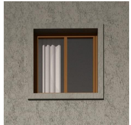
Balkongdörr- och fönsteromfattningar utförs i samma kulör som sockelvåning eller övrig fasad. Omfattningarna utförs som upphöjd relief i puts som ger en skuggverkan på fasad. Referensbild Dinell Johansson.
