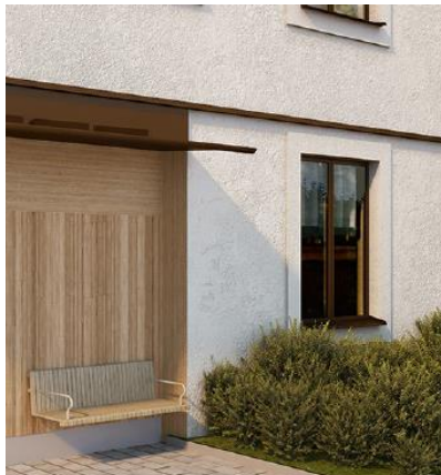
Sockelvåningen markeras med en plåtlist i samma kulör som övriga plåtdetaljer. Bild White.
