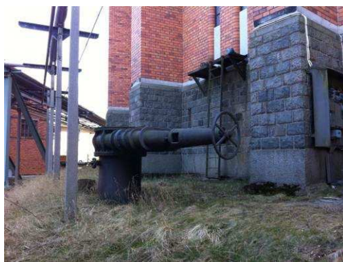
Bild gasregulator invid gasklocka 2.
