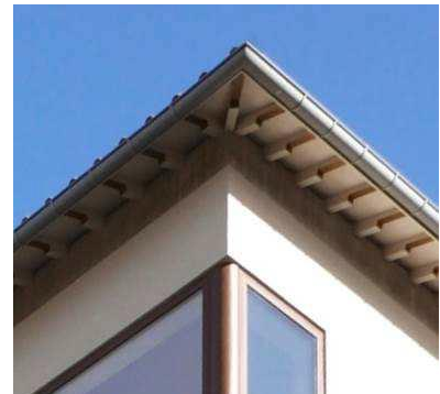
Takfoten ska utformas utstickande med synliga taktassar. Det skyddar fasaden och ger byggnaden ett lättare intryck. (Bild Dinell Johansson)
