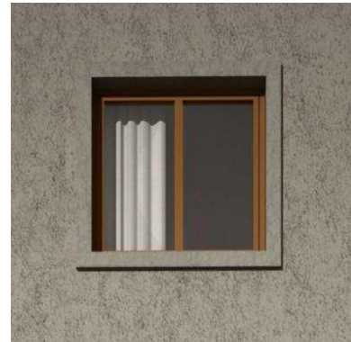
Balkongdörr- och fönsteromfattningar utförs i samma kulör som fasad. Omfattningarna utförs som upphöjd relief i puts som ger en skuggverkan på fasad. (Bild Dinell Johansson)
