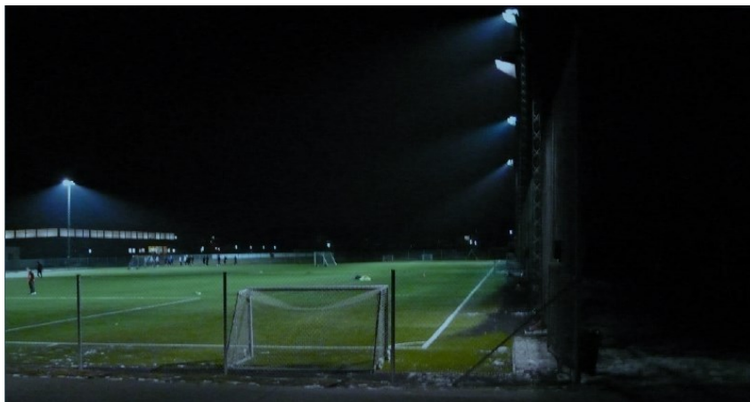
Specialtillverkad mekanisk avskärmning skärmar av en stor del av ljuset som annars hade hamnat utanför planen.
