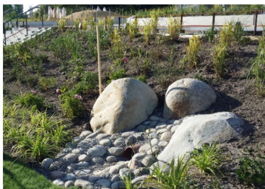
Figur 17. Nedsänkt regnbädd med utloppsledning.
