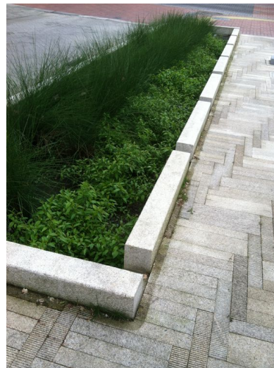
Figur 16. Nedsänkt regnbädd med släpp i kantsten.
