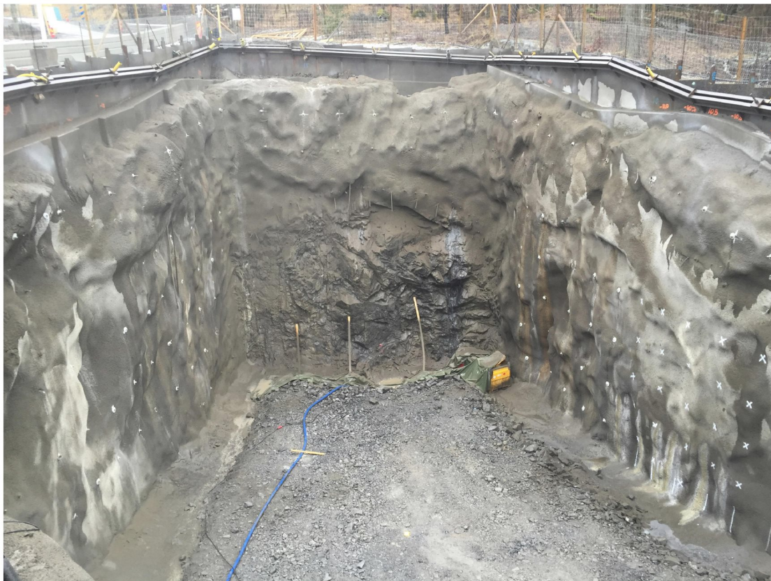
Bild 3. Förskränningen blev klar 2016. Bilden visar den djupaste delen där arbetena med bergtunnlarna påbörjades (rakt fram i bild).
