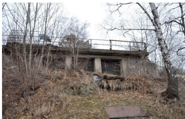
Bild 12. På den högre norra sidan gick tågrälsen. Det finns ännu spår av järnvägens bropelare öster om byggnaden. Järnvägsrälsen gick här på en viadukt in i området
