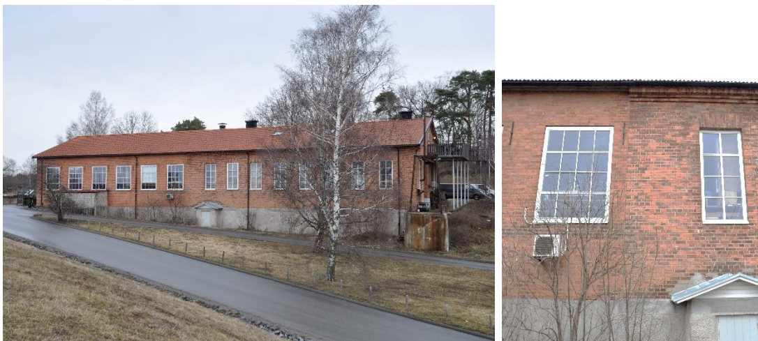
Bild 15. Vagnsverkstaden eller den första destruktionsanläggningens södra fasad. Till höger en inzoomad foto av fasaden som visar den äldsta delen och den nyare i en enklare fasadutformning utan den dekorativa gesimsen vid takfoten.
