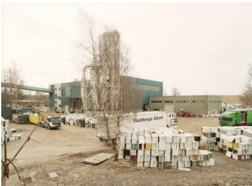
Bild 5. På 1970-talet uppfördes en försöksanläggning för automatisk sopsortering. Soporna kom från söföbränningsanläggningen via transportbandet till vänster i bild. Senare användes
