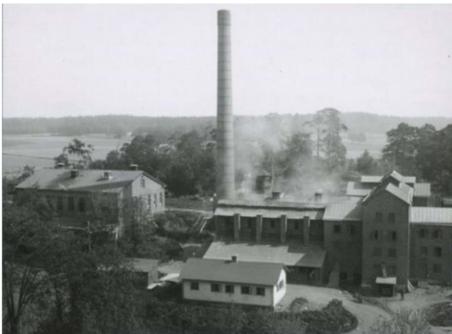
Bild 2. På platsen för dagens båtklubb, som ligger nordvästerut i verksamhetsområdet, där pirar syns i bild 1, låg Lövstas latrinstation och pudrettfabrik. I förgrunden syns lastbryggor för sållsopor. I vänstra hörnet syns den läns som förhindrade sopor att sprida sig i Mälaren. Lövsta 1937. Digitalt stadsmuseum. Fotograf: John Söderberg.
