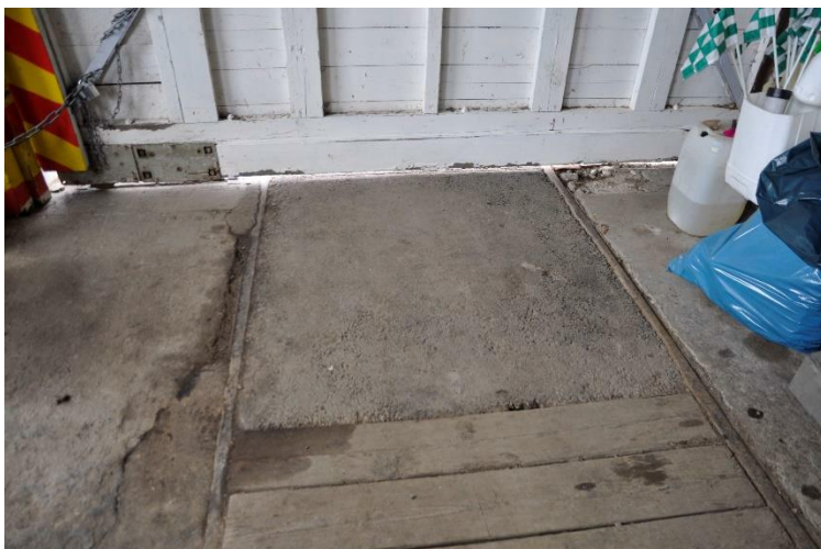
Bild 19. I den del som hyrs av golfklubben är byggnaden mindre förändrad interiört. Här syns tydligt spåren och en trälucka som troligen kunde lyftas vid service av tågen.
