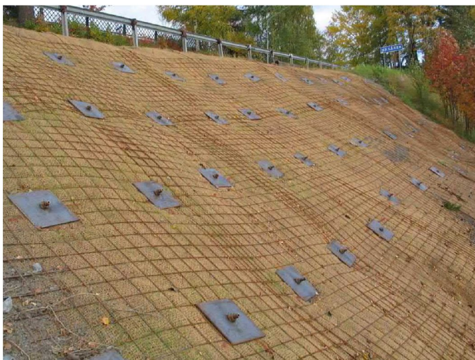
Figur 5.3 Exempel på nätning av slänt (innan vegetation planterats)
