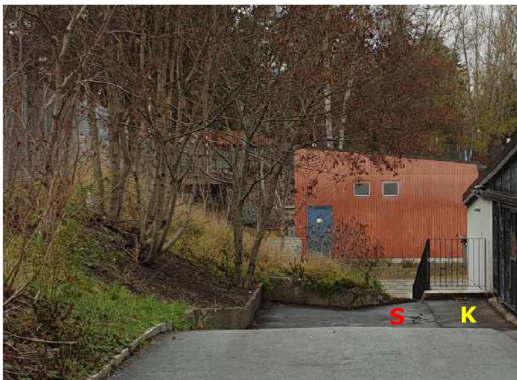
Figur 3.14. Parkeringshusets tillfartsväg på baksidan sett mot Björnsonsgatan. Tunnelbanan till vänster. Kulvertens (K) tak till höger. Sättningar (S) har skett i slutet på tillfartsvägen. Lutning mot dagvattenbrunnen.
