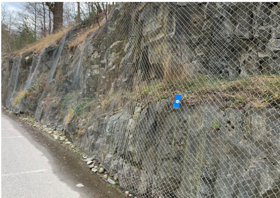
Figur 4 Bergskärning säkrad med nät
