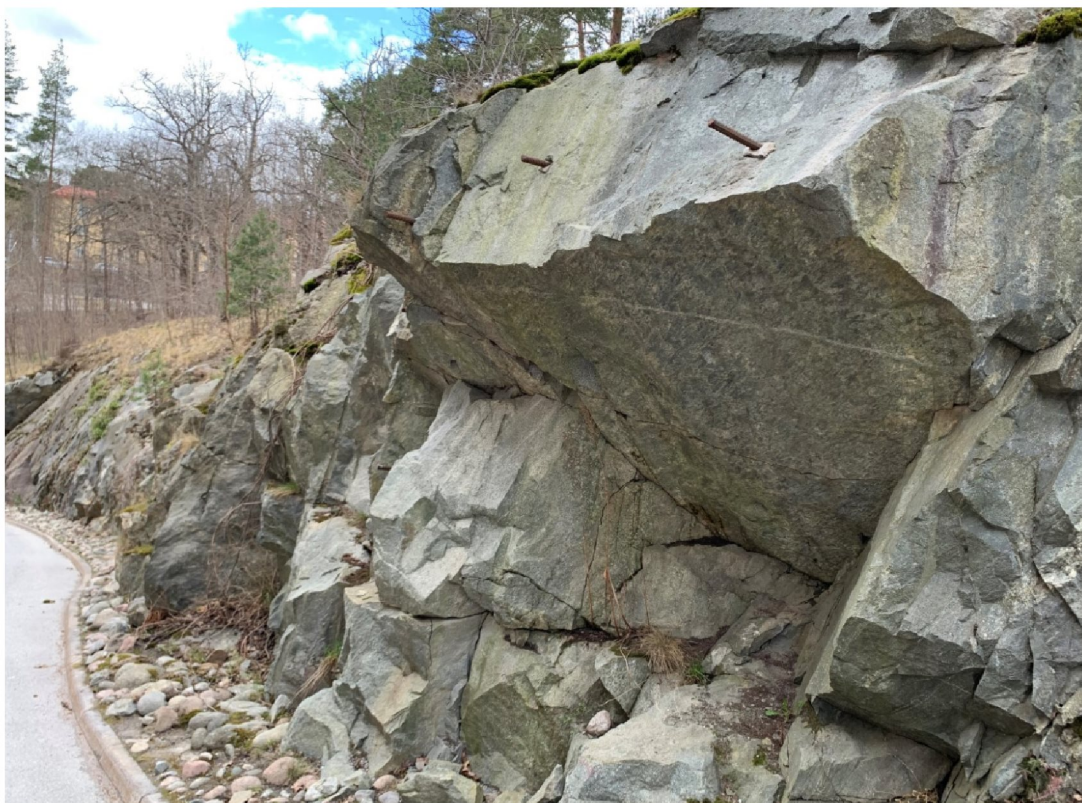
Figur 5 Bergsskärning, bergbultar
