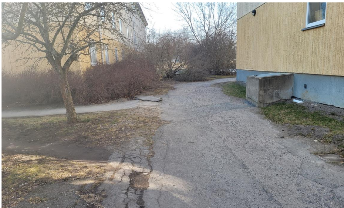
Figur 2: Sättningar i asfalt.
