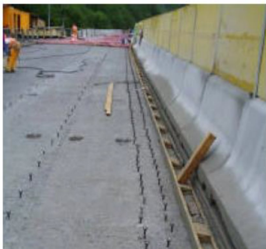
Figur 2: Principutförande för samverkande betongbeläggning. Bild lånad av Hilti från deras hemsida
