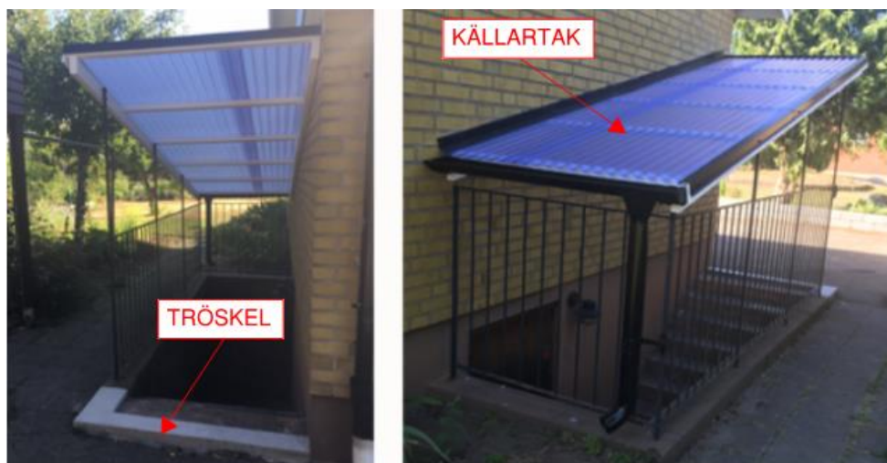
Figur 9. Exempelbild på utformning av tröskel och tak för skydd mot vatten till källare.
