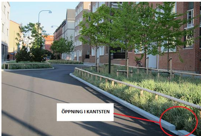
Figur 12. Exempelbild på nedsänkta växtbäddar med öppning i kantsten.
