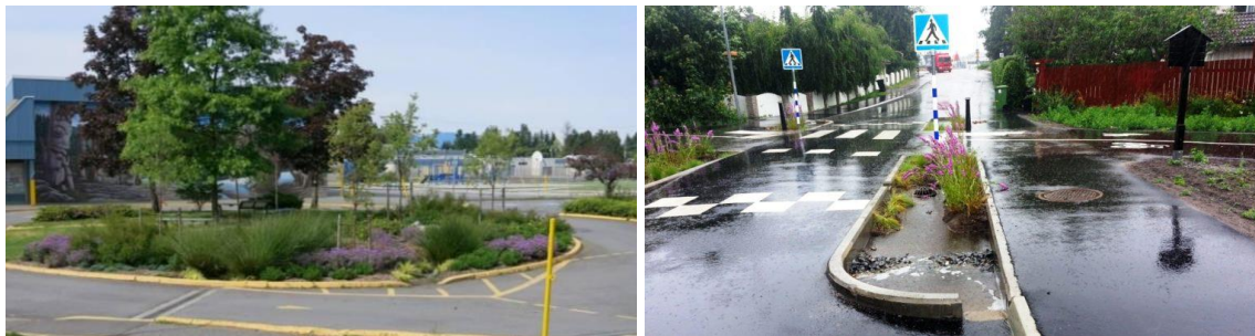
Figur 8-2. Till vänster: Exempel på hur en rondell kan utformas med en regnbädd för dagvattenhantering. Bild från Gibson Elementary School, 2011. Till höger: Regnbäddar som bildar ett farthinder vid ett övergångsställe i Tyresö. Bild från Goda exempel, hämtad 2018-02-27.
