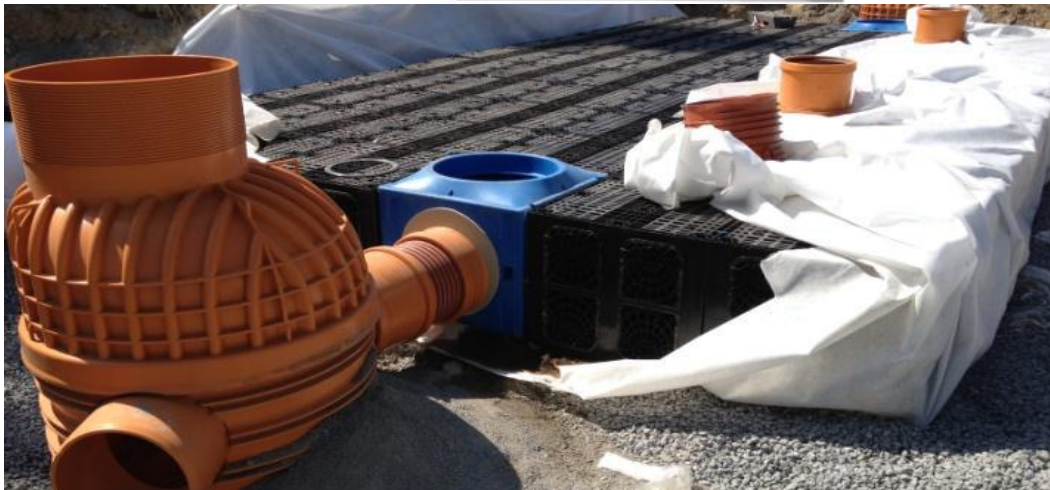
Figur 6 Över: Illustration över hur ett krossmagasin kan se ut (Svenskt Vatten, 2011). Under: Sammankopplade dagvattenkassetter (Svenska Bostäder, 2014)
