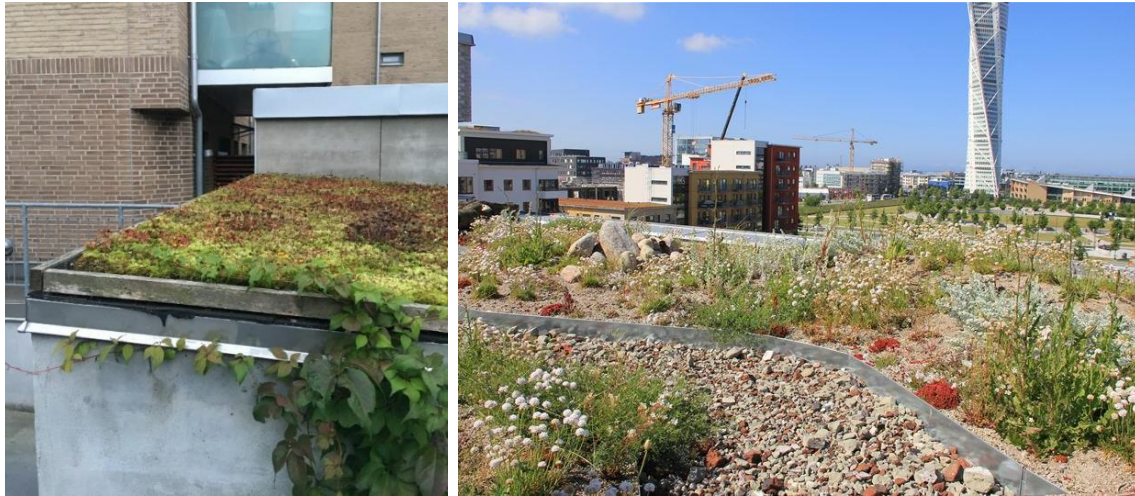
Figur 4. Exempel på synliga gröna tak. Till vänster: Grönt tak på garagedfart i Malmö. Foto: Structor Uppsala AB, 2017. Till höger: exempel på biotoptak. Bild från Vegtechs bildbibliotek, används i utredningen med tillåtelse.
