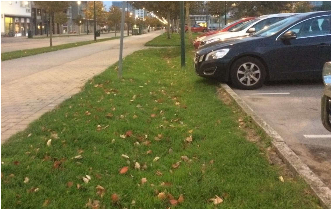
Figur 8-3. Svackdike mellan parkering och gångbana. Diket bör dock utformas utan kantsten eller med släpp med jämna mellanrum för att dagvattnet ska kunna rinna dit. Foto av Structor Uppsala, 2017.
