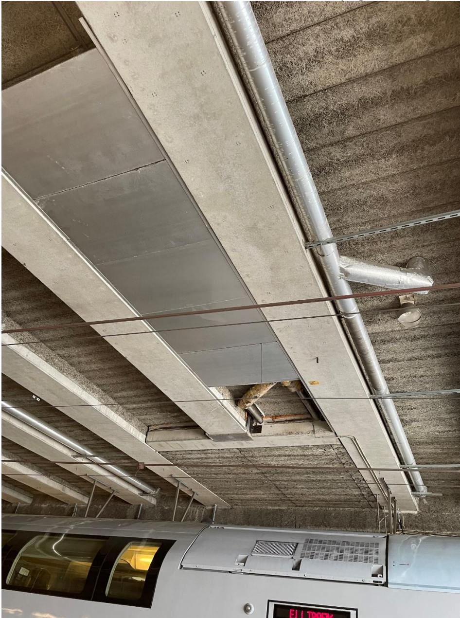
Figur 24 Befintliga dagvattenledningar över spårområdet under Nils Ericson plan
