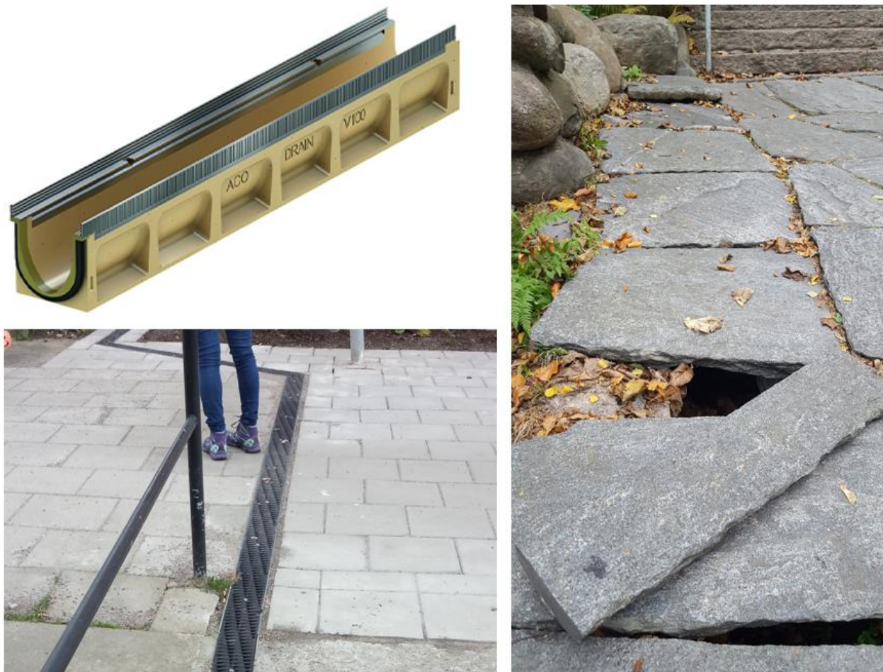
Figur 18 Olika exempel på dagvattenrännor (AcoDrain; Ramboll, 2016; Ramboll, 2016)
