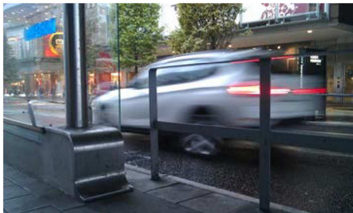
Bild 4. Mellanrum mellan väderskydd och staketet, hållplats Sergels Torg. Bilden visar även att staketet går att klättra på och över samt krypa under.
