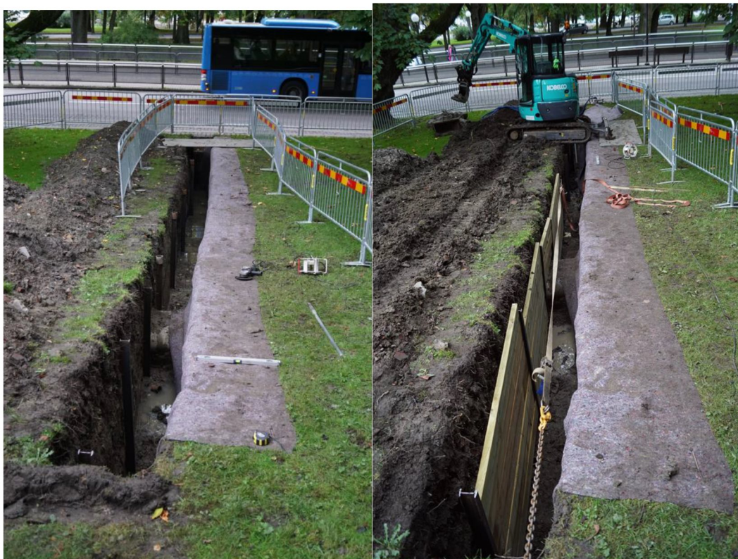
Bild 7. Utförande av skyddsspont steg för steg.
