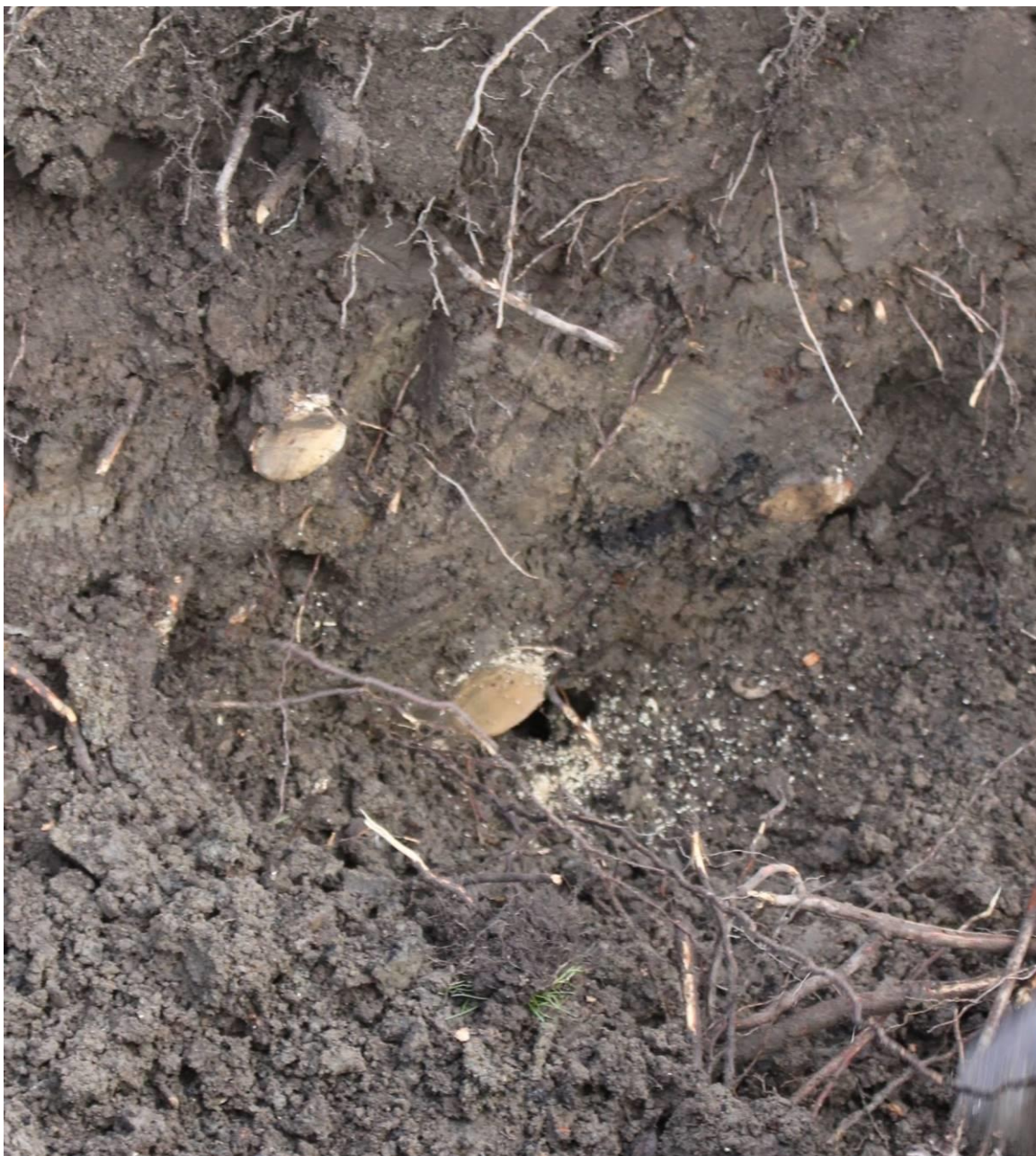
Bild 4. Korrekt beskurna rötter vid schakt.
