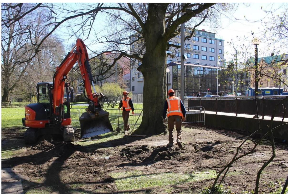
Bild 9. Avtagning av grässvål vid utförande av markvitalisering.
