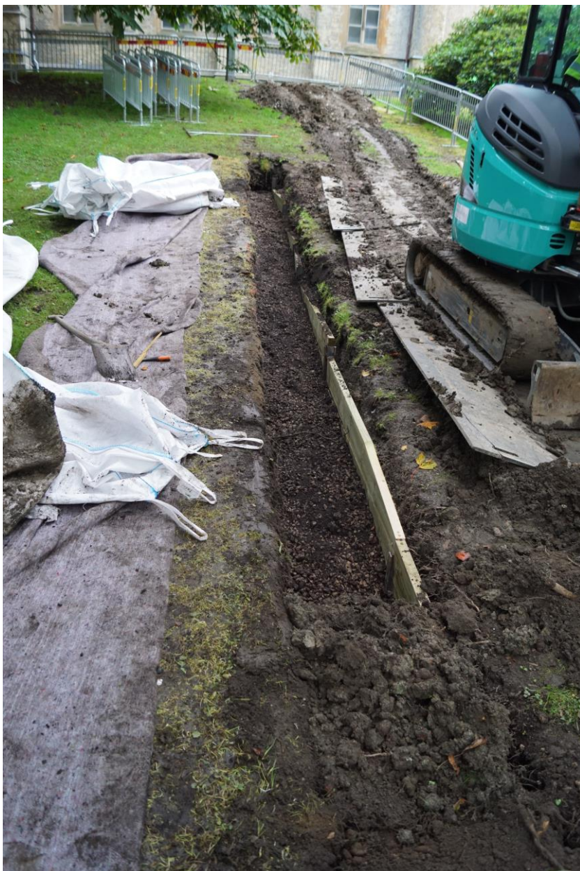
Bild 8. Fyllning mot skyddsspont med pimpstens.
