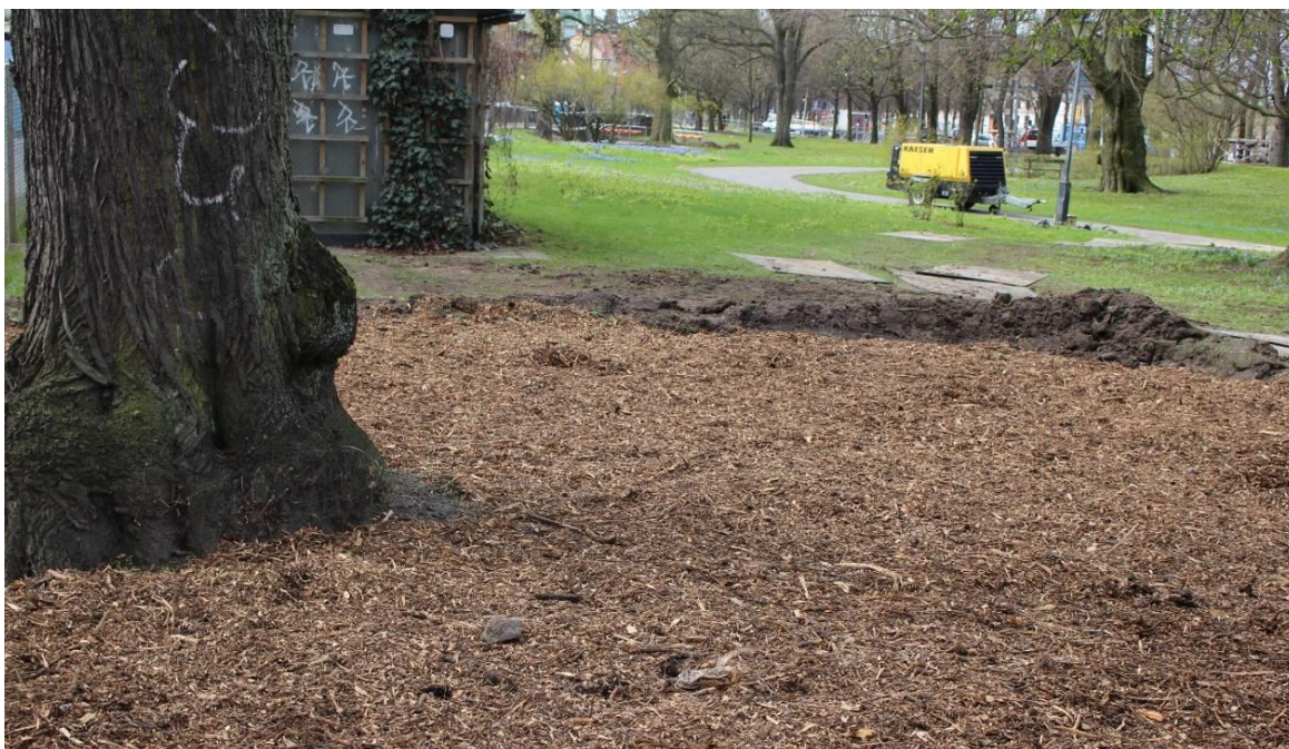
Bild 11. Färdigutlagt mulchlager vid markvitalisering.
