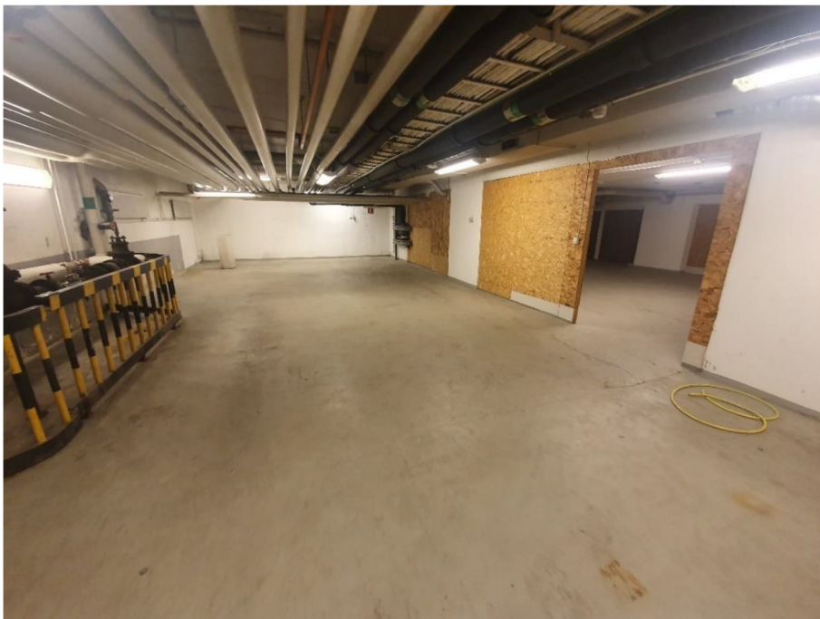
Figur 4. Källarplan (suterräng) som delvis brukas som parkering i dagsläget. Här ses det slipade betonggolvet och OSB-skivorna på väggarna samt ledningar i tak.
