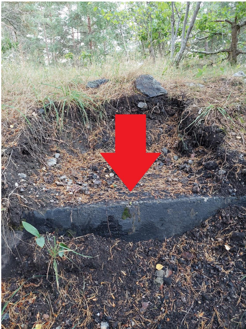
Figur 6. Tidigare provgropp vid det gamla skyttevärnet. Skyttevärnets "tak" syns mellan fyllnadsmassorna och är markerat med en röd pil.
