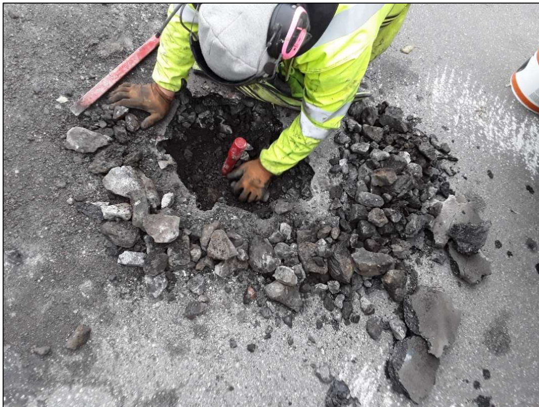
Figur 6 Bild på grundvattenrör i provpunkt LC01 och material som finns runt borrhålet.
