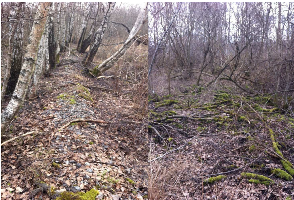
Figur 4.6.1 Hästa träsk. Till vänster en av de långsmala makadamsträngar med dränledning i botten som genomkorsar området och avvattnar det till Järva dagvattentunnel.
