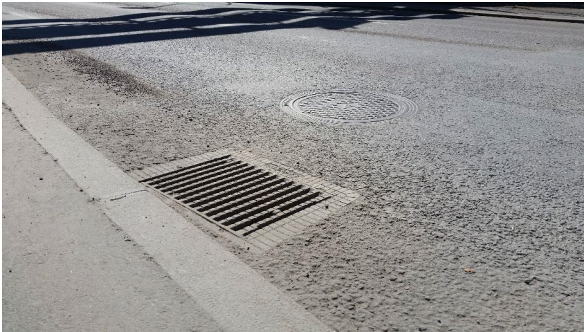
Figur 47. Dagvattnet i området avvattnas med hjälp av konventionella rännstensbrunnar. Foto: Sweco.
