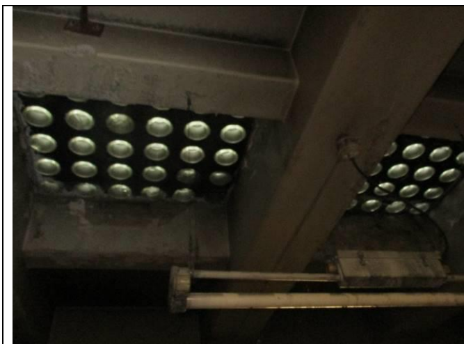
Bild 17. Ljusinsläpp glasmosaik kan innehålla asbest i fogarna runt glaset.
