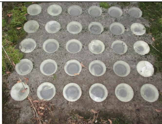
Bild 30. Ljusinsläpp mosaik kan innehålla asbest i fogarna.
