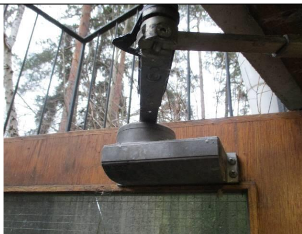
Bild 12. Äldre dörrstoppare kan innehålla PCB olja.
