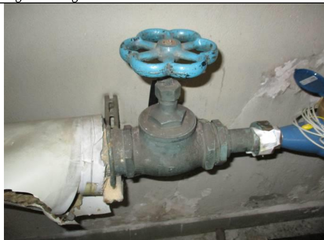
Bild 19. Äldre installation, BV. Flänsar/packningar som kan innehålla asbest.
