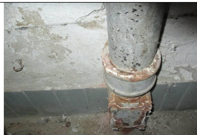
Bild 28. prov 3, tätmassa runt rör källare vån upp via entresol dvs BV.
