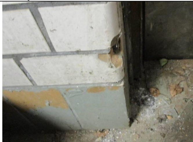
Bild 7. Prov 1. Kakelfog+fix vit rektangel källare suterräng. Ej Asbest.
