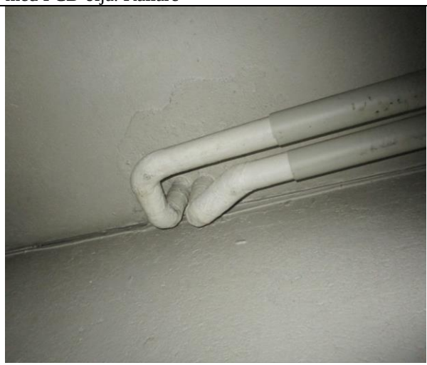
Bild 16. Äldre isolering – asbestrisk, BV.
