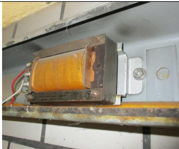
Bild 14. Äldre lysrörarmaturer kan ha kondensator med PCB-olja. Källare
