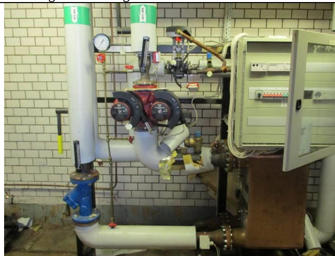
Bild 13. Nyare fjärrvärmeinstallationer, källare suterräng.
