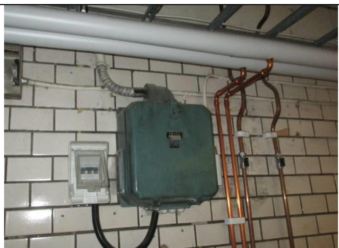
Bild 9. Äldre el-installationer, innehåller bly.
